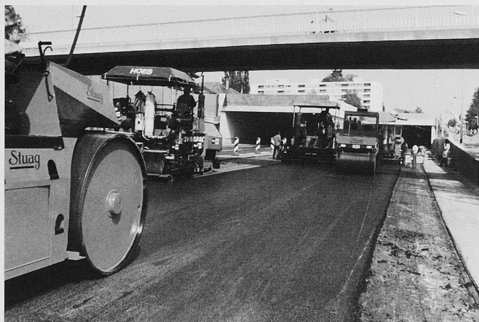
Bild 5. Einbau Splittmastix mit drei Fertignern bei gesperrter Fahrbahn, Bereich Südportal (Mai 1992, Foto M. Frick)
