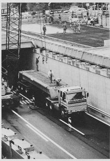
Bild 3. Vorfabrizierte Betonelemente werden montiert und mit dem Überbeton untereinander verbunden (November 1991, Foto H. Müller)
