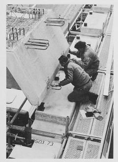
Bild 4. Die Elemente werden auf provisorischen Stahllagern montiert (November 1991, Foto H. Müller)
