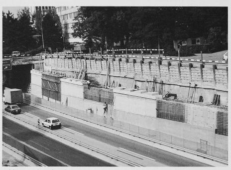
Bild 1. Die bestehenden Stützmauern werden für die neue Aufgabe angepasst (August 1990, Foto H. Müller)
