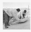
Nach dem Markieren wird der TAFIXE mit einigen Hammerschlägen in der Dämmschicht fixiert. Seine genau der Dicke des Dämmstoffs entsprechende Höhe sorgt für eine ausgezeichnete Ebenheit des Daches.
