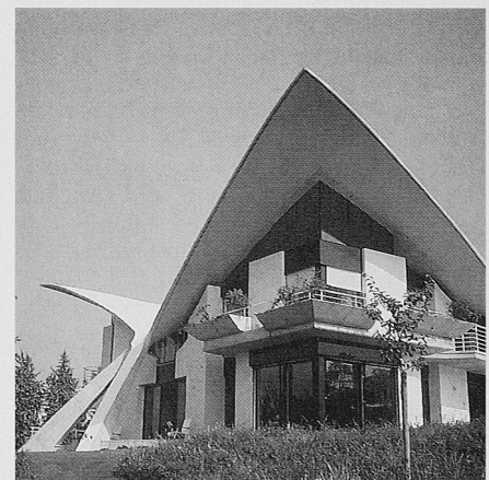
Die Villa Darier in Genf, fertiggestellt 1987, besteht aus einer monolithischen Schale mit vier hyperbolischen Flügeln (s. auch Titelbild dieses Heftes). Ing.-Arbeit: H. Isler, Burgdorf; Entwurf und Architektur: P.A. Camoletti, Genf
