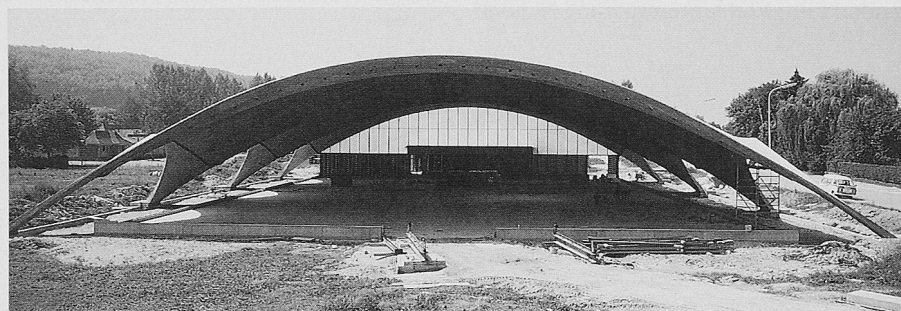
Die Schalen des Rohbaus des Sportzentrums zeigen die Leichtigkeit der Konstruktion mit nur 9 cm Betondicke. Der Horizontalschub wird durch unterirdische Zugbänder aufgenommen. Formentwurf und Ing.-Arbeit: H. Isler; Architekt: J. Copeland, Haus und Herd
