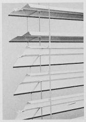
Im oberen Storenbereich reflektieren die horizontalen Lamellen das eintretende Tageslicht zur Decke, und von dort fällt es gleichmässig und reflexionsfrei auf die Arbeitsfläche
