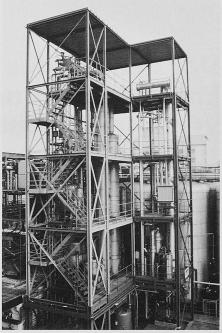
Bild 4. Nachgeschaltete Abluftreinigungsanlage für mit organischen Lösungsmitteln befrachtete Abluft, Baujahr
