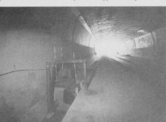
Einbau des speziell für den Tunnelbau entwickelten ACO-Entwässerungssystems bei der N 16
