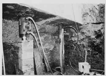
Bild 6. Press- und Injektionsbohrpfähle, Objekt Kirche Teufen
