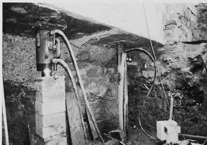
Bild 6. Press- und Injektionsbohrpfähle, Objekt Kirche Teufen
