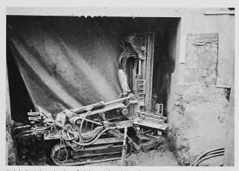
Bild 5. Kleinbohrpfähle, Objekt Schützengasse 21, Zürich
