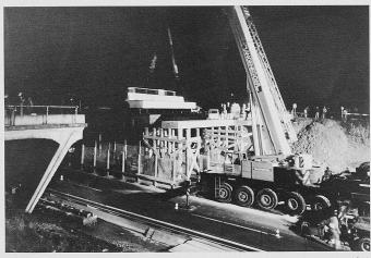
Bild 1. Abbruch der alten Brücke: Auftrennen des Mittelfeldes in sechs Teilstücke und Abheben mit Autokran
