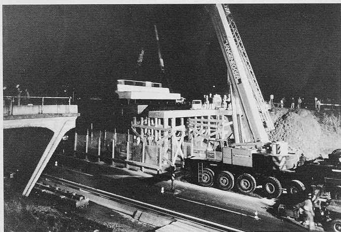
Bild 1. Abbruch der alten Brücke: Auftrennen des Mittelfeldes in sechs Teilstücke und Abheben mit Autokran
