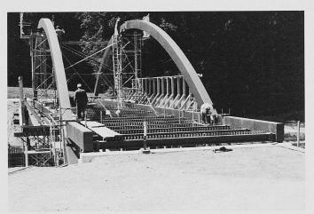
Bild 3. Montage der Bogen, Längs- und Querträger. Montagestösse in den Bogenscheiteln und je fünf Montagestösse in den Längsträgern
