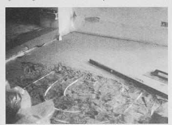
«Europlan» ist ein speziell für kleine Flächen geeignetes Unterlagsbodenmaterial
