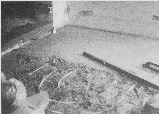
«Europlan» ist ein speziell für kleine Flächen geeignetes Unterlagsbodenmaterial
