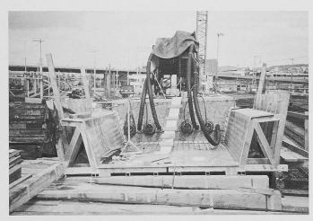
Bild 11. Brücke Überwerfung Mitte in Zürich-Herdern: werksgefertigte Spannglieder mit spiegelgeschweissten Kunststoffhüllrohren auf Rollen
