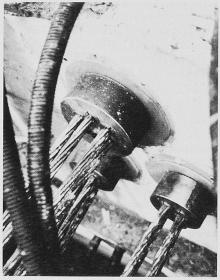
Bild 9. Überführung «du Milieu»: Elektrisch isolierte Spannverankerung
