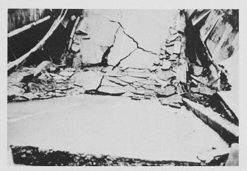
Bild 1. Eingestürzte Ynis-y-Gwas-Brücke in Wales
