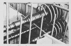
Bild 8. Uberführung «du Milieu»: Hüllrohr und Ankerstutzen aus robustem Kunststoff
