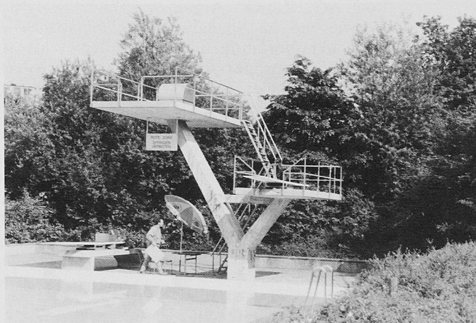
Bild 2. Sprungturm mit Tilger
