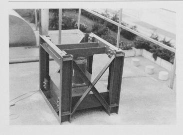
Bild 3. Ansicht des Horizontaltilgers auf dem Sprungturm
