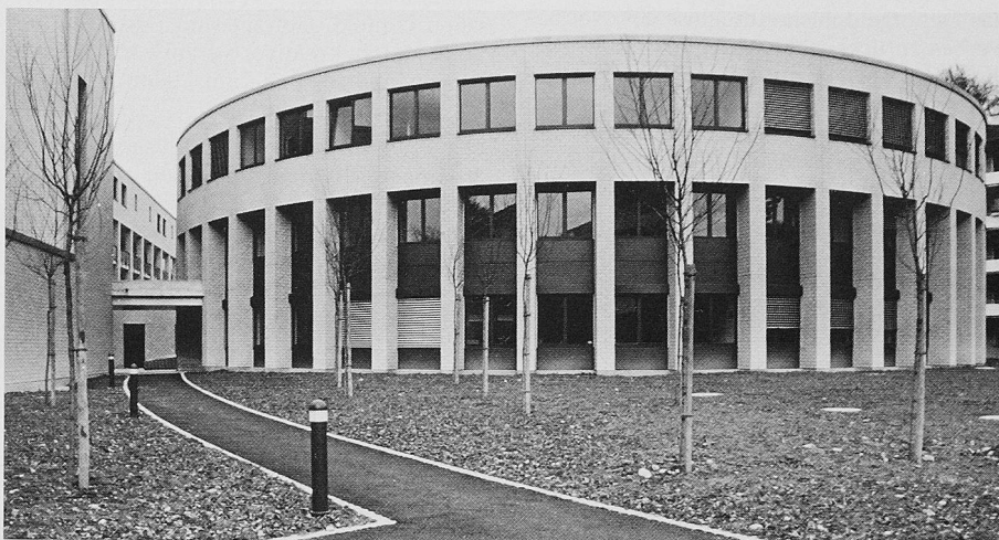
Der halbrunde Baukörper des Büroteils der Volg-Überbauung nimmt als Motiv die Form des ganz in der Nähe gelegenen, markanten Winterthurer Gebäudes der Gebr. Volkart auf
