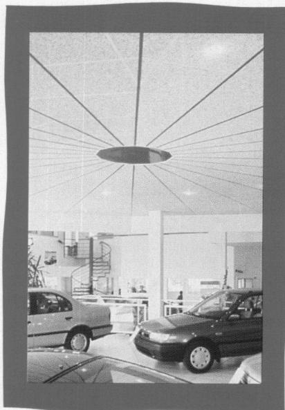
Die Akustik- und Industriedeckenplatten werden als abgehängte Decken in handelsübliche Sichtschiene- Einlegesysteme verlegt.
