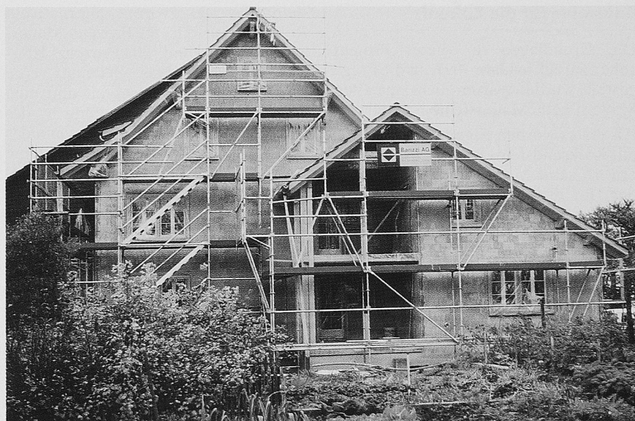
Beim alten Bauernhaus von Jakob Grimm in Oetwil a.S. wurde der Wohnteil abgebrochen und neu aufgebaut. Das Abbruch-Mauerwerk wurde von der Hard AG zu Maro ® -Steinen verarbeitet, mit denen die Brandmauer zwischen Scheune und Wohntrakt aufgeführt wurde.
