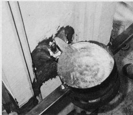
An die neue Fiale aus Obernkirchner Sandstein angeformtes sog. Schwalbennest zum Eingiessen des Bleis, darunter die mit Ton abgedichtete Horizontalfuge, damit das Blei nicht ausläuft; Einfüllen des Bleis; Verstemmen der mit Blei gefüllten Horizontalfuge
