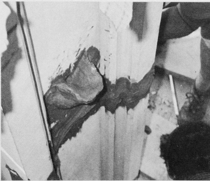
An die neue Fiale aus Obernkirchner Sandstein angeformtes sog. Schwalbennest zum Eingiessen des Bleis, darunter die mit Ton abgedichtete Horizontalfuge, damit das Blei nicht ausläuft; Einfüllen des Bleis; Verstemmen der mit Blei gefüllten Horizontalfuge
