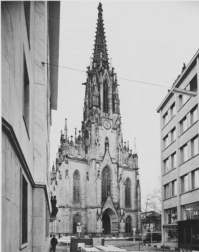
Ostfassade, Zustand nach der Restauration
