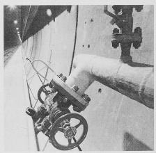
Bild 10. Löschwasserhydrant im Tunnel
