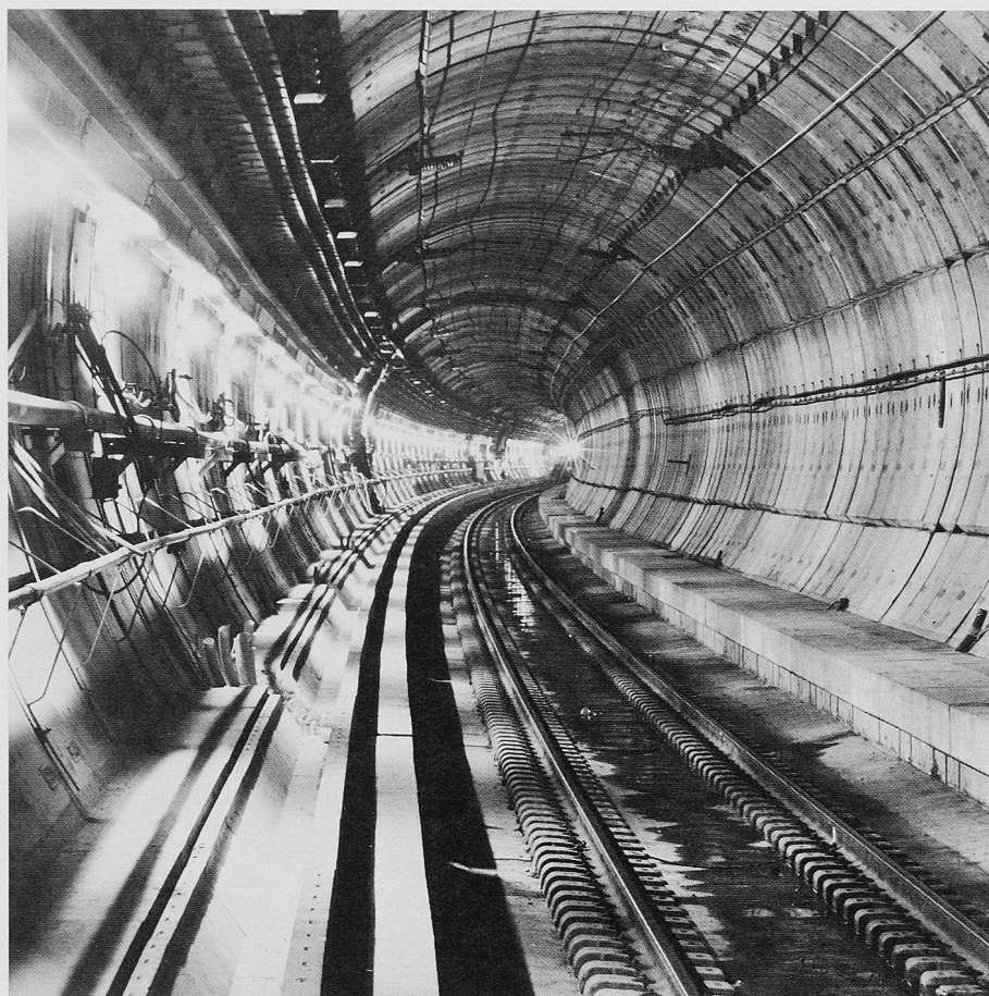
Bild 1. Blick in einen der beiden eingleisigen Eisenbahntunnel mit Stützring aus hochfesten Stahlbeton-Tübbingungen und beidseitigen Randwegen, kurz vor der Inbetriebnahme
