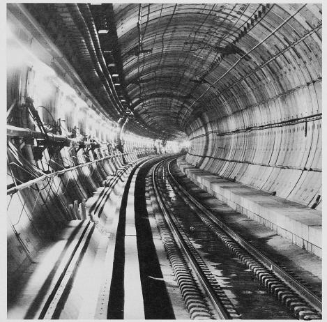
Bild 1. Blick in einen der beiden eingleisigen Eisenbahntunnel mit Stützring aus hochfesten Stahlbeton-Tübbingen und beidseitigen Randwegen, kurz vor der Inbetriebnahme
