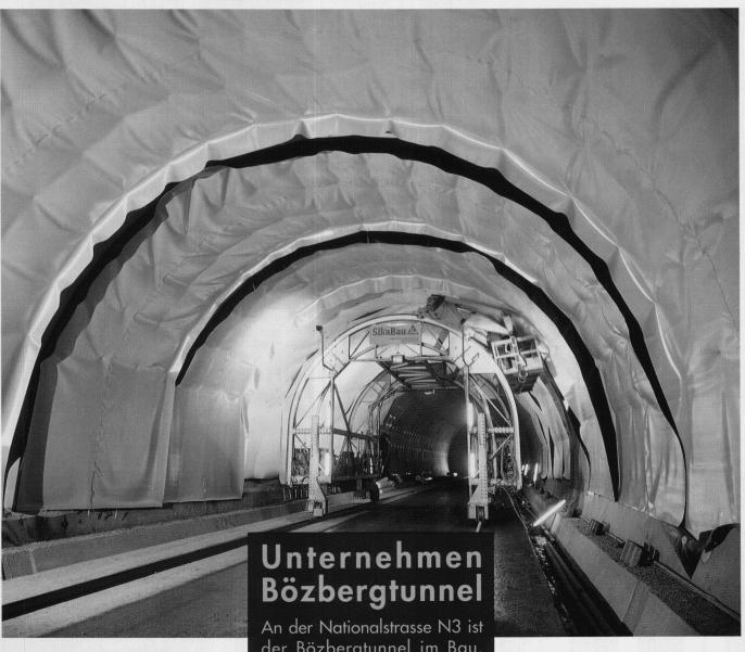
An der Nationalstrasse N3 ist der Bözbergtunnel im Bau. SikaBau erstellt die Abdichtungen. Der Tunnel wird auf der ganzen Länge von 3,5 km durchgehend und in der ganzen Abwicklung (Kreisprofil) mit Sikaplan 24.6 V Tunnelfolie und Sikaplan 14.6 V Tunnelfolie abgedichtet.
