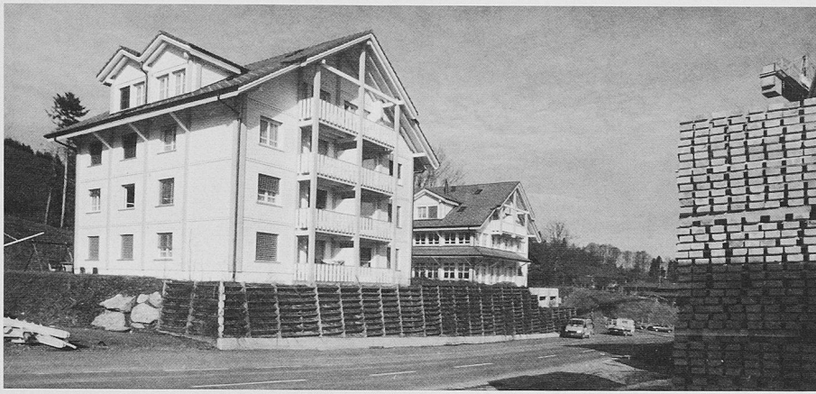
Die Realisierung der beiden Küssnacher Wohnbauten in mehrgeschossiger Holzbauweise war nur dank eines speziellen Brandschutzkonzeptes möglich
