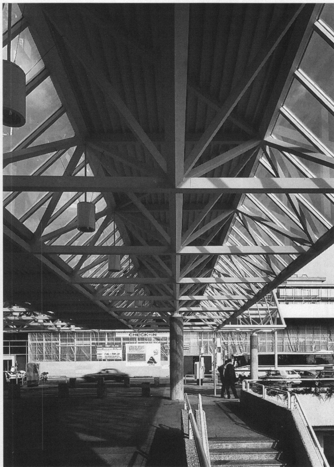
Fachwerke aus RHS-Profilen beim Bus-Terminal Flughafen Genf-Cointrin
