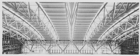
Bild 3. Hamburg-Fuhlsbüttel: geschwungenes Flächentragwerk für den Terminal (Alle Bilder: Mannesmannröhren-Werke AG, Mülheim)
