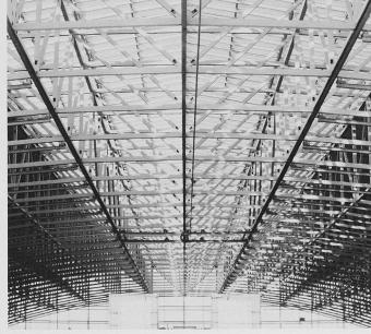
Bild 1. Frankfurt: 2400 t feuerverzinkter Stahl für die Dachkonstruktion
