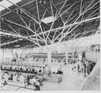
Bild 2. Stuttgart: filigrane Baumstützen aus Rundrohr im Flughafenterminal
