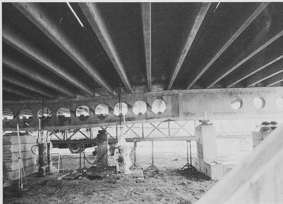
Bild 10. Verstärkung der Träger. Der Untergurt wird von einem U-förmigen Stahlträger umfasst. Der Zwischenraum ist mit Fliessmörtel ausgegossen. Die Verstärkung muss im Raum zwischen Rohrleitungen und Unterdecke eingepasst werden
