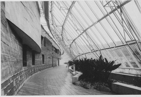
Bild 3. Die Schrägverglasung nutzt die passive Sonnenenergie. Die Fenster lassen sich automatisch von innen beschatten. Links die Lehmwand mit grosser Wärmespeicherfähigkeit. Das Raumklima wird zudem verbessert durch die Bepflanzung und einen kleinen Wasserlauf in der Brüstung
