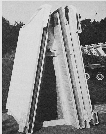
Die fertig beplankten Elemente stehen zur Montage bereit
