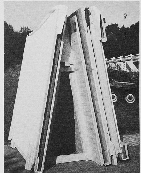
Die fertig beplankten Elemente stehen zur Montage bereit
