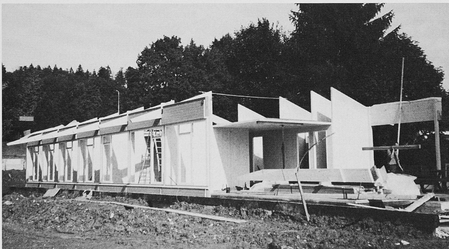
Bauzustand des Zumiker Massivholzelement-Hauses nach ungefähr elf Stunden Montagezeit
