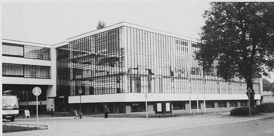
Das Bauhaus in Dessau von Gropius, 1925 (In den Situationsplänen der Entwürfe links unten!). In unmittelbarer Nähe befindet sich das Areal für den Wettbewerb «Akademie am Bauhaus». (Aufnahme: B. Odermatt)
