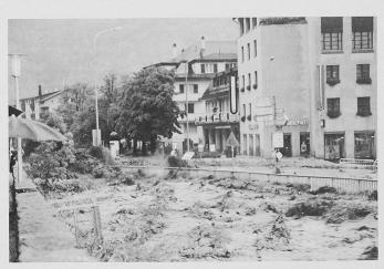
Bild 4. Die Saltinabrücke am 24. September 1993 kurz nach 16 Uhr. An der Brücke (erkennbar am Geländer) staut sich das Wasser und beginnt kontinuierlich auf die Brücke zu strömen. Blick in Fliessrichtung. (Foto I. Niederberger, Brig-Glis)
