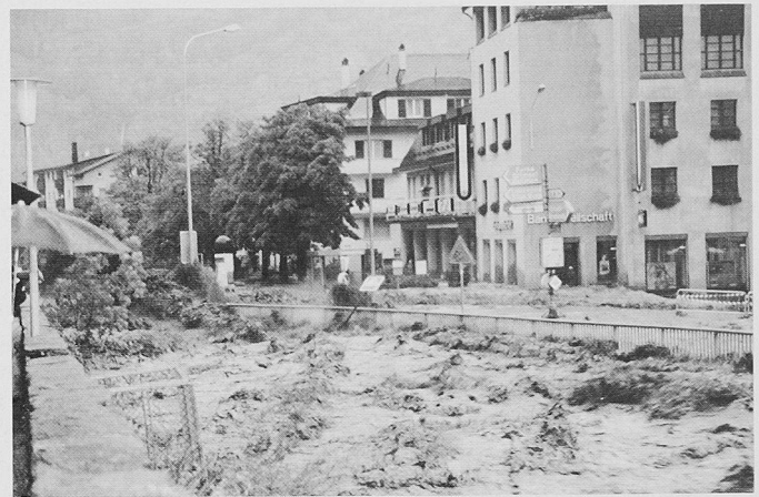
Bild 4. Die Saltinabrücke am 24. September 1993 kurz nach 16 Uhr. An der Brücke (erkennbar am Geländer) staut sich das Wasser und beginnt kontinuierlich auf die Brücke zu strömen. Blick in Flussrichtung. (Foto I. Niederberger, Brig-Glis)
