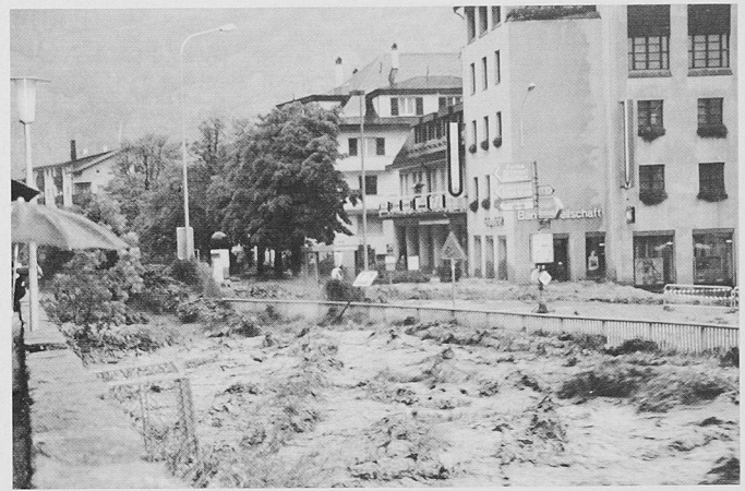
Bild 4. Die Saltinabrücke am 24. September 1993 kurz nach 16 Uhr. An der Brücke (erkennbar am Geländer) staut sich das Wasser und beginnt kontinuierlich auf die Brücke zu strömen. Blick in Fließrichtung. (Foto I. Niederberger, Brig-Glis)
