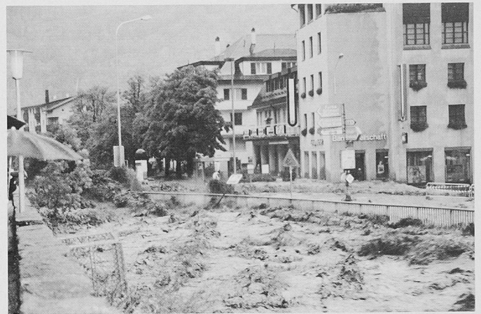
Bild 4. Die Saltinabrücke am 24. September 1993 kurz nach 16 Uhr. An der Brücke (erkennbar am Geländer) staut sich das Wasser und beginnt kontinuierlich auf die Brücke zu strömen. Blick in Fliessrichtung. (Foto I. Niederberger, Brig-Glis)
