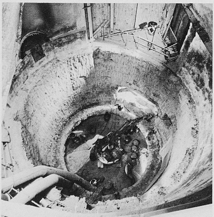
... und nach Beendigung der Abbauarbeiten am Beton des biologischen Schilddes
