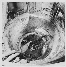
... und nach Beendigung der Abbauarbeiten am Beton des biologischen Schildes
