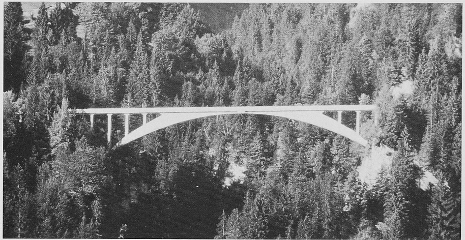
Bild 2. Salginatobel-Brücke, Spannweite 90 m, Baujahr 1930
