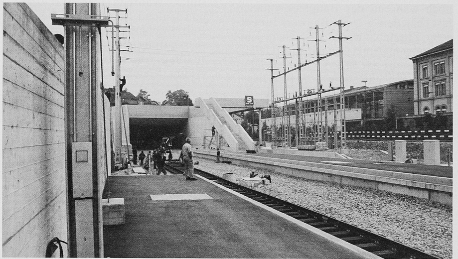
Bild 5. Tunnelportal Ost im Rohbauzustand Mai 1993
