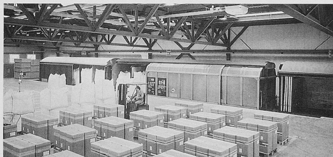
Bild 6. Stahlkonstruktion der Bahnhalle
