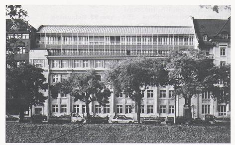
Die Hauptfassade des umgebauten Geschäftshauses am Stauffacherquai 42/44. Die nötige Aufstockung wurde – mit Rücksicht auf die erhaltenswerte neuklassizistische Fassade vom Anfang dieses Jahrhunderts – zurückgesetzt und in einer feingliedrigen Aluminium-Konstruktion ausgeführt
