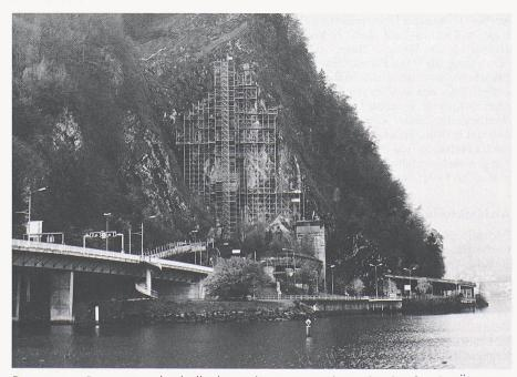
Das riesige Baugerüst oberhalb des Achereggtunnelportals, das für die Überprüfung der Felsanker installiert wurde (Bild Comet)
