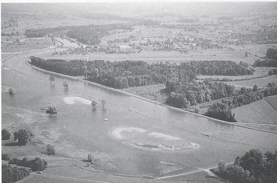
Bild 6. Reusstalsanierung (AG) und ländliche Neuordnung (Bild Ifk)
