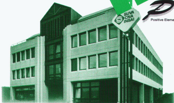
Geschäftshaus Adlikerkreuz, Regensdorf. Rötlich eingefärbte, sandgestrahlte Sandwich-Fassaden.
