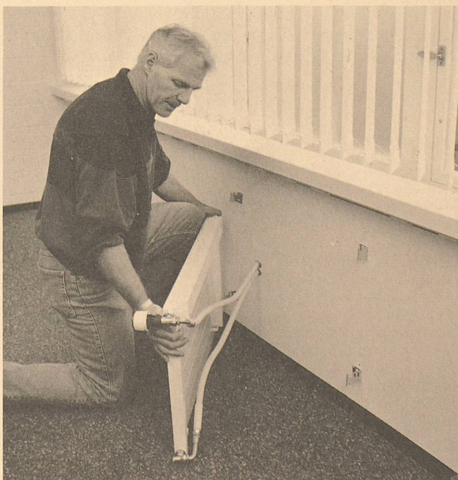
Die Heizkörper sind im Betriebszustand abhänger
