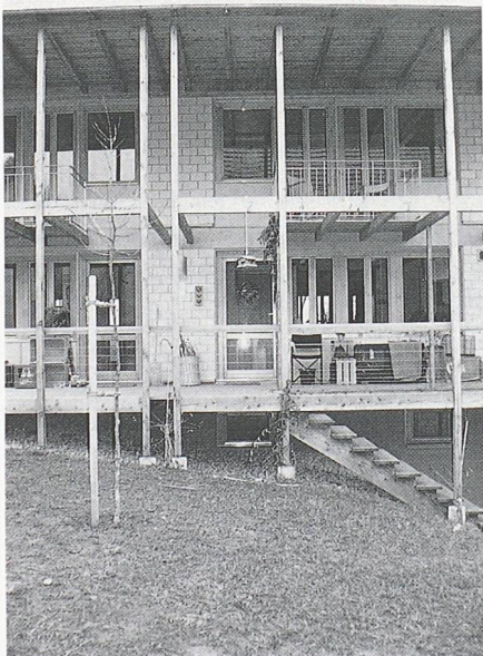
Bild 6. Die Holzkonstruktion (Lärchenholz) der Laubengangszone ist exakt auf dem gewachsenen Boden abgestützt (Bilder 3, 4, 5 und 6: Marc Meyer, Gabriela Weber Meyer)
