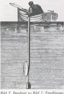
Bild 2. Pendant zu Bild 1: Empfängerboot für Signalempfang und Zeitmessung (Stoppuhr)
