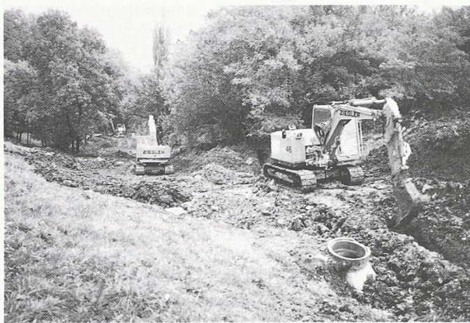
Bild 5. Beispiel Hinterer Wartenberg, Gemeinde Muttenz: Arbeiten in schwierigem Gelände und schattigem, NE-exponiertem Hang (Bild 5a) unmittelbar nach der gelungenen Rekultivierung, die ein sorgfältiges Arbeiten mit der Moorraupe und einen erfahrenen Maschinisten erfordert (Bild 5b)
