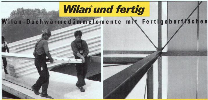
Wilan-Dachwärmedämm-Fertigbauelemente mit Hochwärmedämmkern mit Dampfsperre und Unterdach, mit Bitumenglasvlies und Aluminium-Untersichtkaschierung, weiss lackiert, oder als grossformatiges Fertigdachelement mit beidseitiger Dünnspanplattenbeschichtung, weiss lackiert, oder das Fertigdachelement mit Aussenund Innenbeplankung aus profiliertem Stahlblech. Montage: auf alle Unterkonstruktionen und Schalungen.
