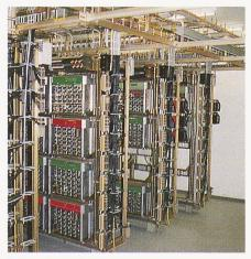
Bild 4. Relaisraum der neuen Sicherungsanlage
