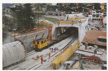
Bild 11. Fertigstellung der neuen Gleise nach dem Einschieben der Brücke im April 1993
