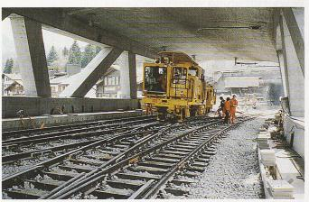
Bild 12. Stopfen der neuen Gleisdurchschneidung auf der Landquartbrücke beim grossen Umbau im April 1993
