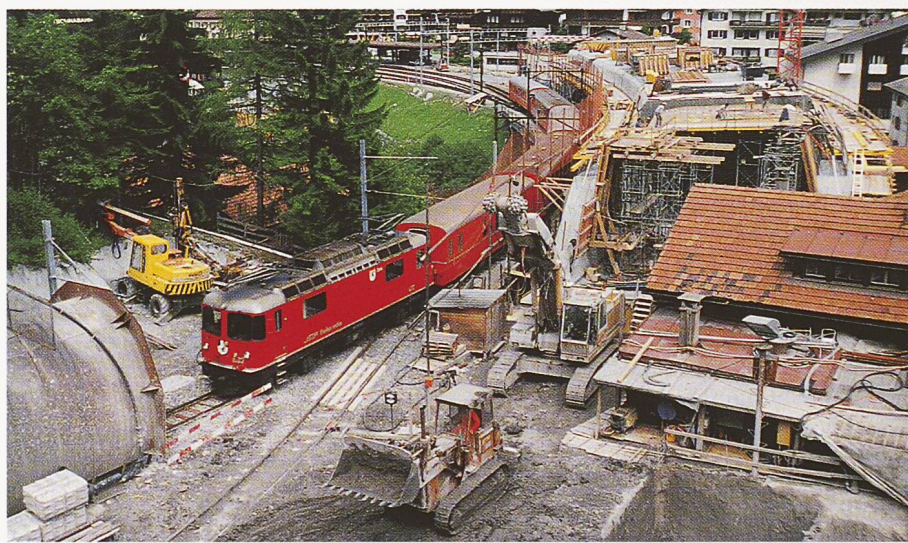
Bild 6. In der 1. Bauphase verkehren die Züge über die alte Landquartbrücke. Die Baustelle Zugwaldtunnel wird über ein Stumpengleis beliefert
