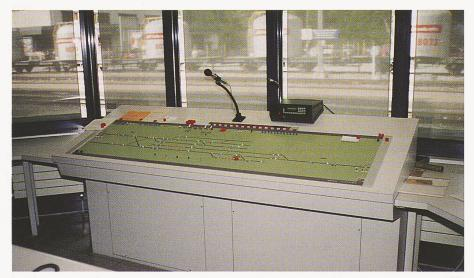
Bild 3. Ortsstellpult der neuen Sicherungsanlage Klosters
