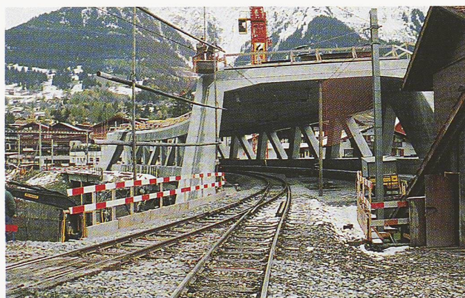
Bild 10. Die Züge verkehren mit engen Radien über die neue, noch nicht eingeschobene Landquartbrücke, während die alte Brücke abgebrochen wird (2. Bauphase)
