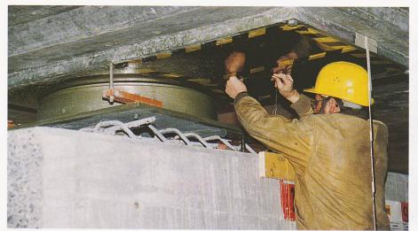
Bild 7. Millimetergenaues Ansteuern der Endlage bei Verschubmeter 10,00 (Foto: Zschokke)
