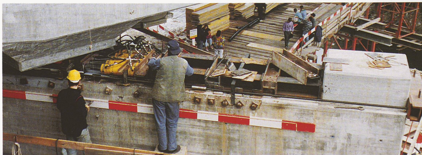
Bild 4. Querverschubbahn Seite Davos mit Abstütznocken, Füllelementen, Pressenbatterie und Führungswinkeln; aktuelle Verschiebedistanz 3,6 m (Foto: Zschokke)
