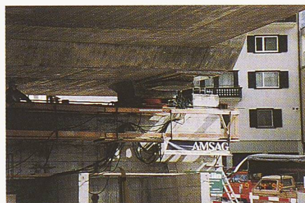
Bild 2. Abstützung des Brückenträgers über das rote Taktischlager auf den Querverschubträger (Foto: F. Gruber)
