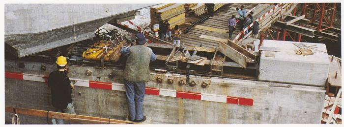
Bild 4. Querverschubbahn Seite Davos mit Abstütznocken, Füllelementen, Pressenbatterie und Führungswinkeln; aktuelle Verschubdistanz 3,6 m (Foto: Zschokke)
