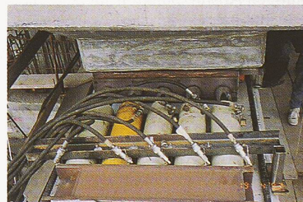
Bild 3. 5 x 800 kN-Pressen übertragen die Verschiebekraft auf das kurvenäussere Taktischlager (Foto: F. Gruber)
