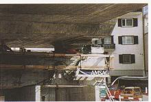
Bild 2. Abstützung des Brückenträgers über das rote Taktschublager auf den Querverschubträger (Foto: F. Gruber)
