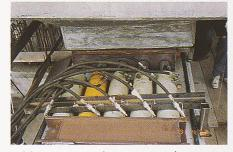
Bild 3. 5 x 800 kN-Pressen übertragen die Verschubkraft auf das kurvenäussere Taktschublager (Foto: F. Gruber)
