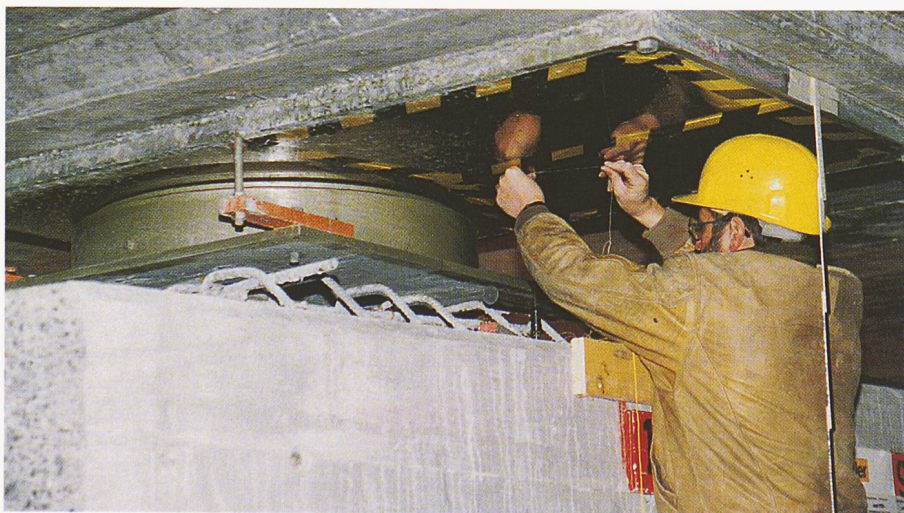
Bild 7. Millimetergenaues Ansteuern der Endlage bei Verschiebeter 10,00 (Foto: Zschokke)
