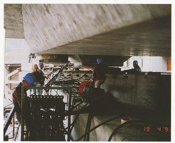
Bild 5. Querverschubausrüstung Seite Davos, Verschubbahn kurveaussen (Foto: F. Gruber)
