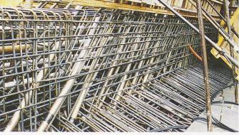
Randträger an Trogplatte; Details von Armierung/Vorspannung
