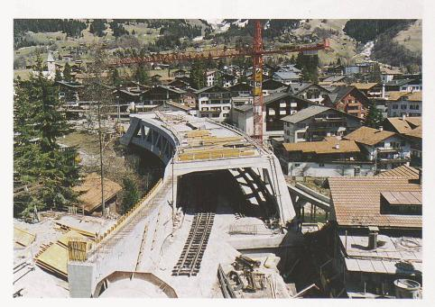
16 Stunden später: Die Brücke ist 10 Meter flussabwärts verschoben. Gleisbau Seite Davos
