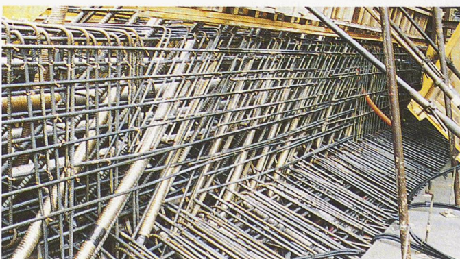
Randträger an Trogplatte; Details von Armierung/Vorspannung
