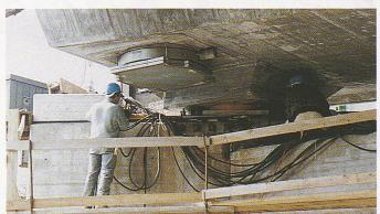
Die Brücke wird auf speziellen Verschublagern bewegt. An der Trogplatte untergehängt ist der obere Teil des definitiven Lagers
