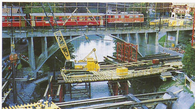
Blick auf die alte Bogenbrücke mit Zugeinfahrt in den Bahnhof Klosters, auf Dienstbrücke/Lehrgerüst und auf die Fussgängerbrücke im Bau (August 91)
