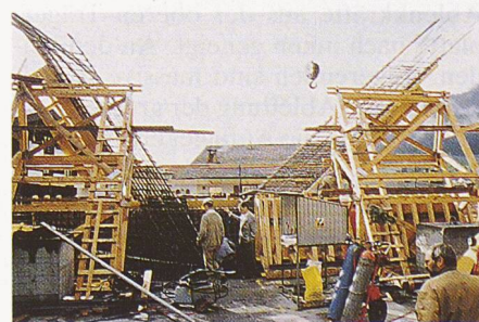
Bild 15. Zugstrebe mit 2'600 kN-Kabeln links, Druckstrebe mit Gewindestäben rechts (Foto: W. Maag)
