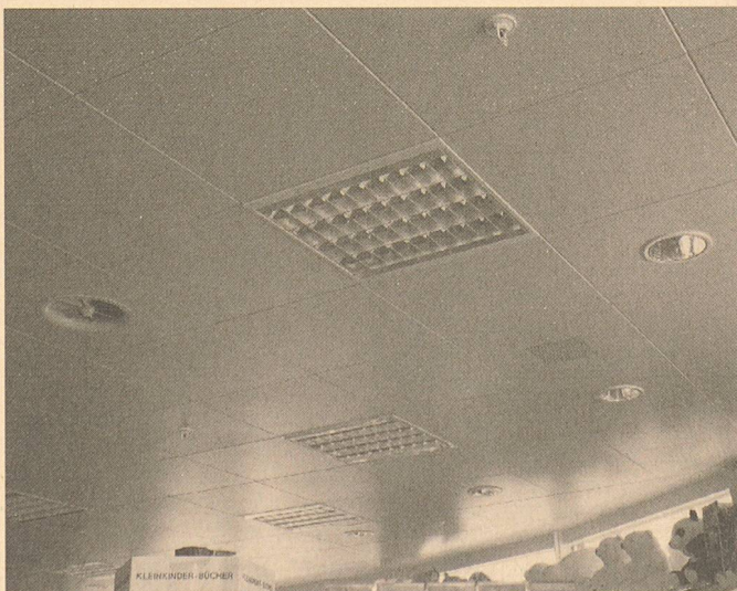
Einsatz der Klemmsystem-Metaldecke «Q-Clip» beim Warenhaus ABM, Ollen
