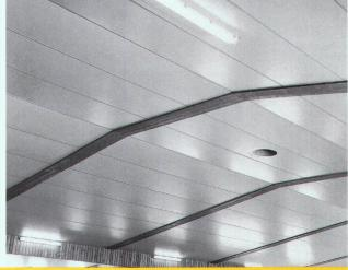
Wilan-Deckenwärmedämm-Fertigbauelemente mit Hochwärmedämmkern werden mit Fertigoberflächen in den verschiedensten Materialien produziert, zum Beispiel: mit Dünnspanplatten, mit Kunststoffdeckschichten, mit Zementfaserplatten, mit Aluminiumfolien oder mit Fertigputzdeckschichten. Montage: auf alle Unterkonstruktionen auch zum Einlegen in Betonschalungen.
