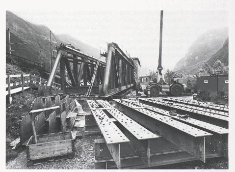
Die Brücke bei Erstfeld, «Modell 136», besteht aus einer Vielzahl von Eisenteilen (Gewicht 400 Tonnen), welche direkt auf dem Bauplatz mit Tausenden von Schrauben zusammengebaut werden (Bild: Comet)
