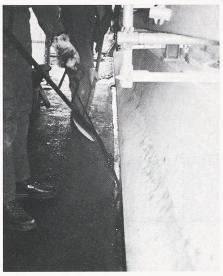
Bild 9. Auffüllen des Randbereichs mit heissem Polymerbitumen
