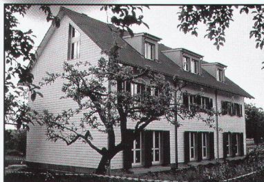
Niedrigenergie-Wohnsiedlung in NOAH-Technologie
