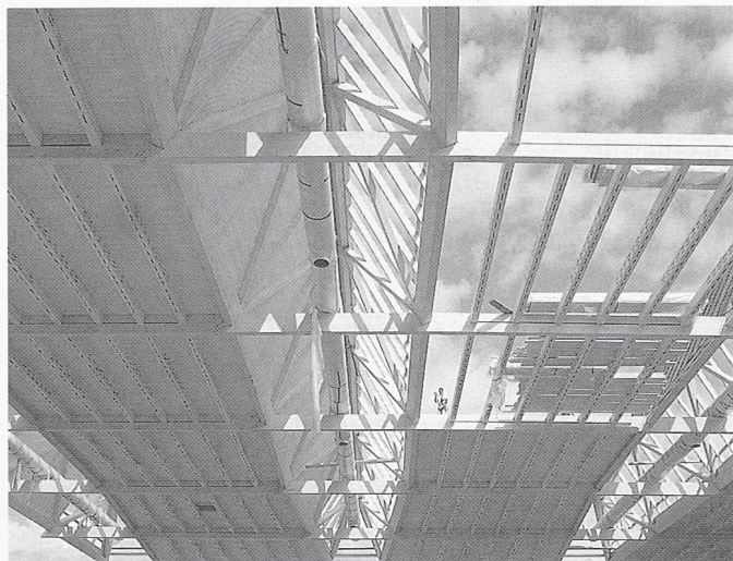
Bild 2. Die voll sichtbar bleibende Holzkonstruktion des Hallendaches mit Binder und den dazwischenliegenden Flachdachbereichen (Die Dimensionen der Konstruktion werden im Hintergrund Mitte durch einen Arbeiter veranschaulicht, der auf dem rechten Flachdachbereich steht)
