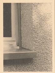
Hinterlüftete Fassaden können nun auch verputzt werden. Hier ein Beispiel mit Inkalite-Steni mit in der Korngrösse wählbarem Natursteingranulat
